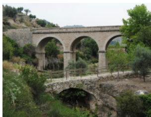
PUENTE DE SELLA Pont de Sella Sella Bridge
